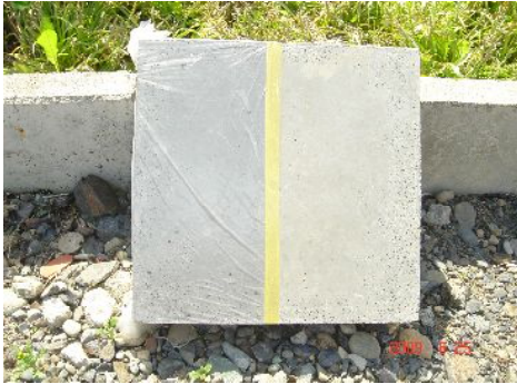
まず、施工の違いを見るために半分を養生し施工準備をした。
