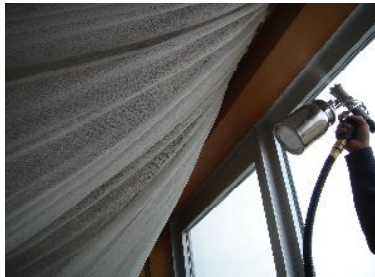
カーテン施工
