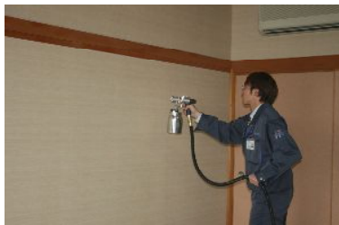
クロス壁面施工
