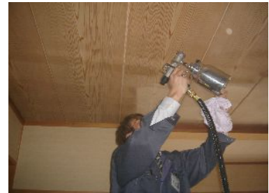
木板面天井施工
