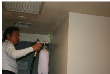
玄関壁面・天井施工
