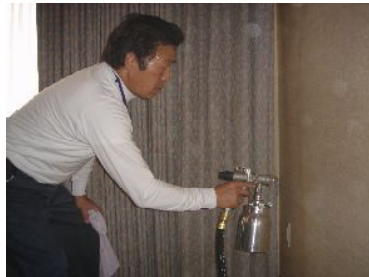
クロス壁面施工
